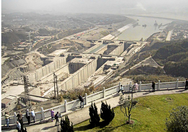
Schiffsschleusensystem der Talsperre während der Bauphase (Nov. 2002)
