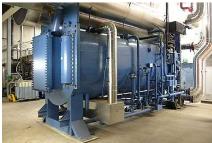
Lithiumbromid-Absorptionswärmepumpe mit einer Kälteleistung von 14.000 kW
