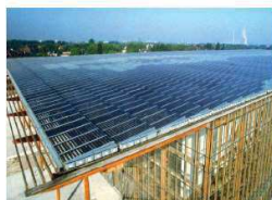
1 MW PV-Anlage auf der Fortbildungsakademie Mont Cenis in Herne Strangwechselrichter auf dem Dach
