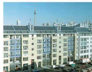
Karl-Philipp-Moritz-Haus in Berlin-Kreuzberg. Fassadenintegrierte PV-Anlage mit Modulwechselrichtern zur Einspeisung in die UV der Wohnungen
