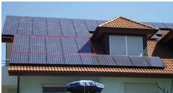
Abbildung 2: PV-Dachanlage mit idealer Südausrichtung, mehreren Teilgeneratoren an Multistring-Wechselrichtern und Verschattung insbesondere des markierten Teilgenerators durch die Dachgauben
