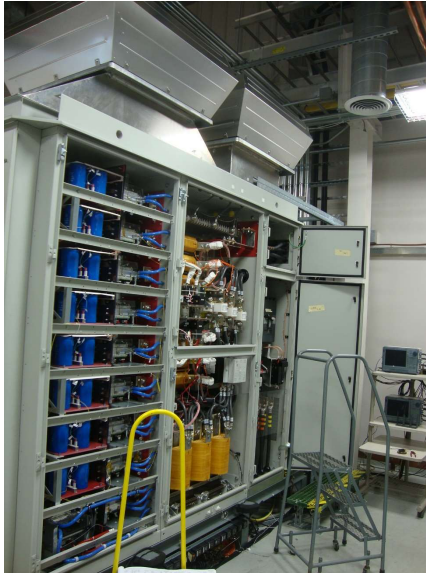
IGBT-Umrichter: Schaltschrank unten im Turm
